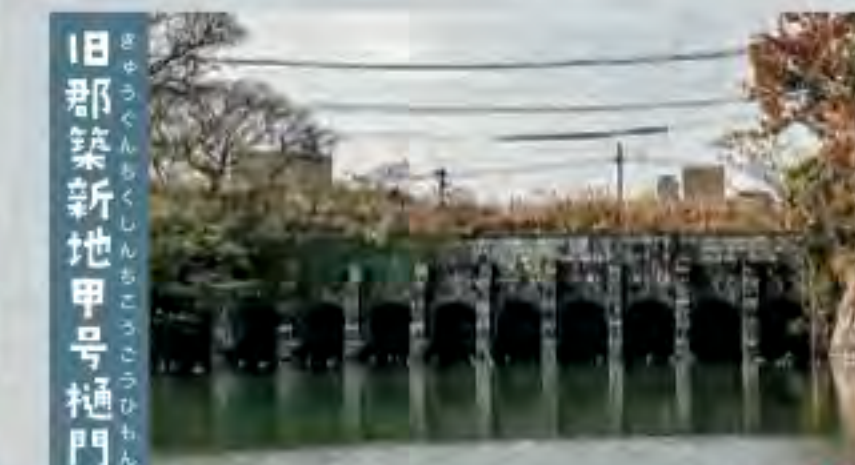
10連アーチの石造りの樋門は、明治時代に行われた干拓事業の際に建造されたもので、切石橋の精巧な技術が発揮されています。現存する石造樋門としては国内最大級。このことから干拓事業の規模や、当時活躍した石工たちの技術力の高さがうかがえ、現代の暮らしの礎を築り返すことができます。[※国指定重要文化財]
