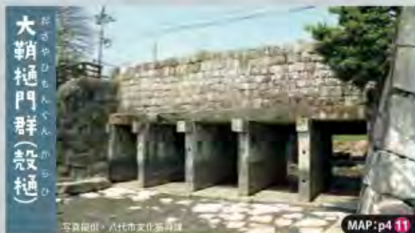
文政2年(1819年)の四百町新地干拓事業の時に建造された樋門。普段は城郭以外に使用しない巨石を用いて強固に築かれているのが特徴。これらの樋門を建造する際に、石工たちが巨石の加工や運搬、石材の積み上げなどに携わったそうです。ちなみに、市指定無形民俗文化財の「大鞘節(おざやぶし)」「大鞘名所(おざやめいしよ)」は、干拓事業に従事した労働者たちが歌った民謡。[※県指定史跡]
