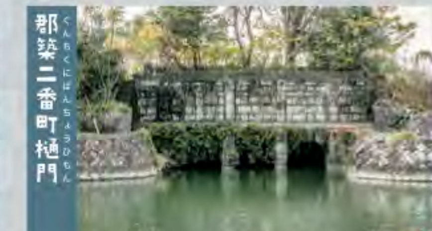
高潮の被害により、決壊した堤防の補強のため、昭和13年(1938年)に建造された樋門。石造り3連アーチ式の構造です。この当時、他地域で建造された樋門の多くがコンクリート造であるのに対し、石で造られているところからも、八代の発展に貢献し続けてきた石工たちの長い間の活躍を感じ取ることができます。[※国登録有形文化財]
