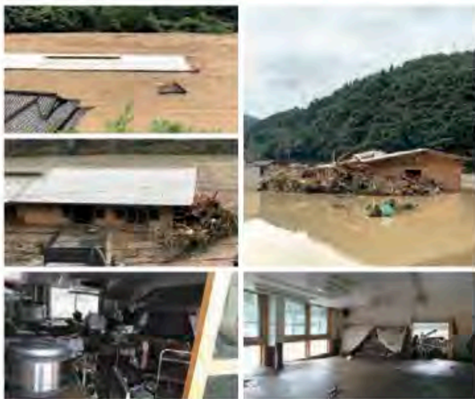
被災した園舎
