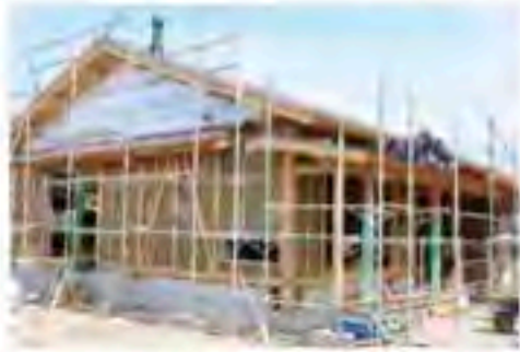
現在施工を担当している家。施主さんと細かく打合せしながら家造りを進めています。
