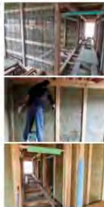
〈中〉数ヶ月経ち置いた土質の土壁に施された藁縄を剥き取り、(下)乾燥した藁縄に土中塗りをした後、藁縄と漆喰を混ぜて仕上げることで壁の肌合効果もあるそう。
