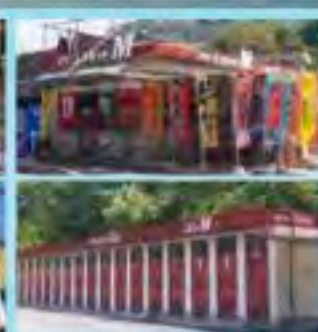
海の家「マリンスポットM」とシャワー施設
