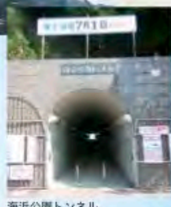
海浜公園トンネル
