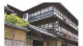
国の有形文化財である建造物。現在熊本県内に現存する旅館の中で最大級の規模を誇ります。
