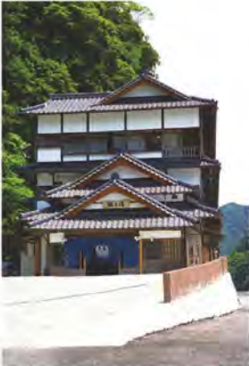
2メートルのかさ上げ工事に加え、もしもの時に備え自家発電ができる電気自動車や太陽光発電などを取り入れ、災害に強い木造3階建旅館として再スタートを切った鶴之湯旅館。
